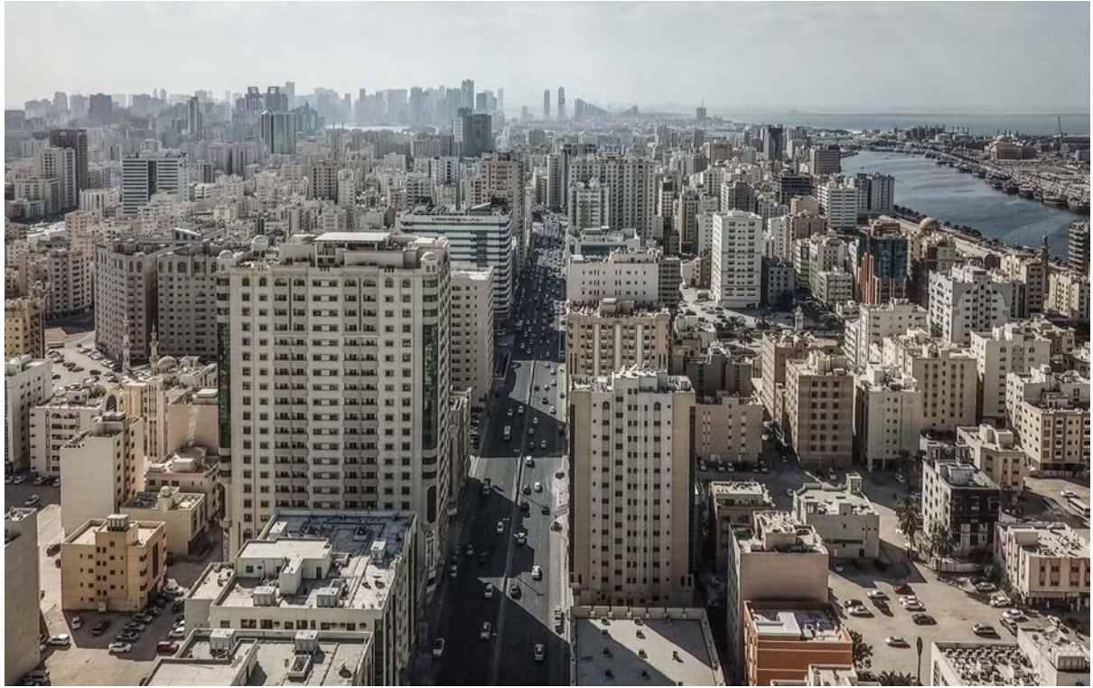
لقطة من الجو لشارع الشرق الذي يطل على ميناء خالد، إمارة الشارقة
